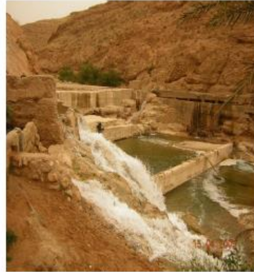
Figure 10: La déviation de l'eau de l'oued Abdi (Branis)
