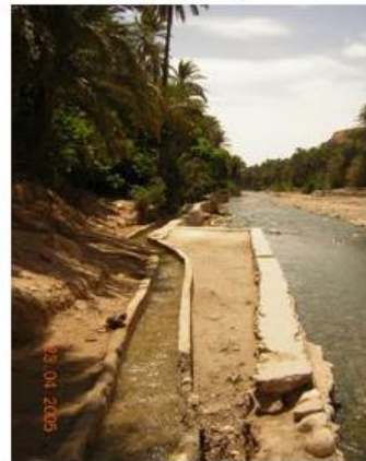
Figure 07 : L'eau déviée de l'oued prend son chemin dans les seguias conçues en béton à ciel ouvert (Mchounech)
