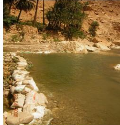
Figure 06: La déviation de l'eau d'oued avec des diguettes à bas de sacs de sable à Mchounech
