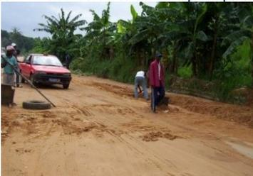
**Figure 4 :** Ensablement de voies bitumées, provoquées par le dépôt de sédiments, produits d'érosion, juin 2006 (Photo N'BRI B. E)
