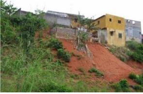
**Figure 1.** Habitations construites en amont de pente, menacées d'écroulement, sous l'action de l'érosion de versant qui s'y opère (Santé II, juin 2005) (Photo N'BRI B. E)
