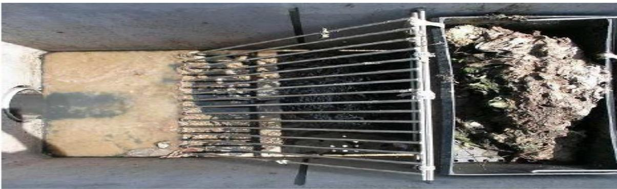
Figure 4 : Dégrillage manuel par grille oblique en acier inoxydable [8] .
