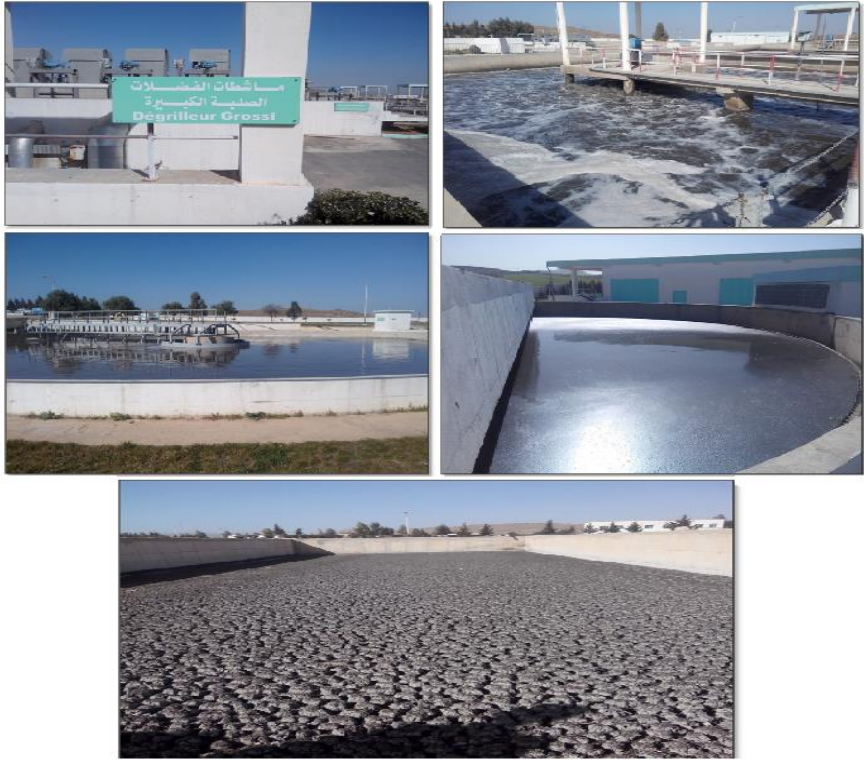
Fig.03- Photos de la filière de traitement des eaux usées de la STEP de Khenchela
