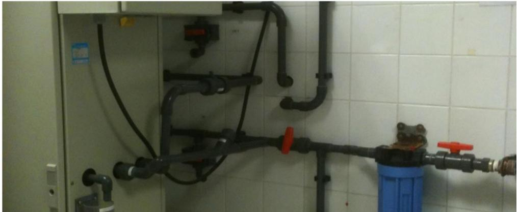
Figure 03 : Unité d'osmose inverse et le pré filtre [4]
