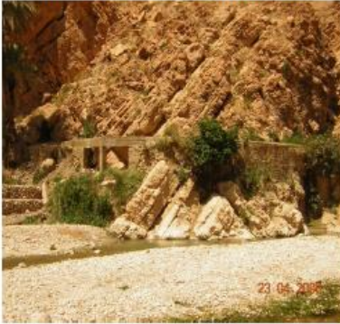
Figure 08: Les conduites en béton sur les deux rives de l'oued Labiod (Mchounech)
