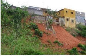
Figure 1. Habitations construites en amont de pente, menacées d'écroulement, sous l'action de l'érosion de versant qui s'y opère (Santé II, juin 2005) (Photo N'BRI B. E)
