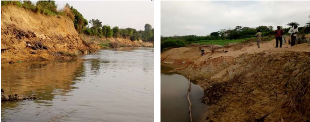
Photo 17 : Erosion de la rive gauche à Sagon et à Ahogo - Prise de vue : Blalogoé, janvier 2021
